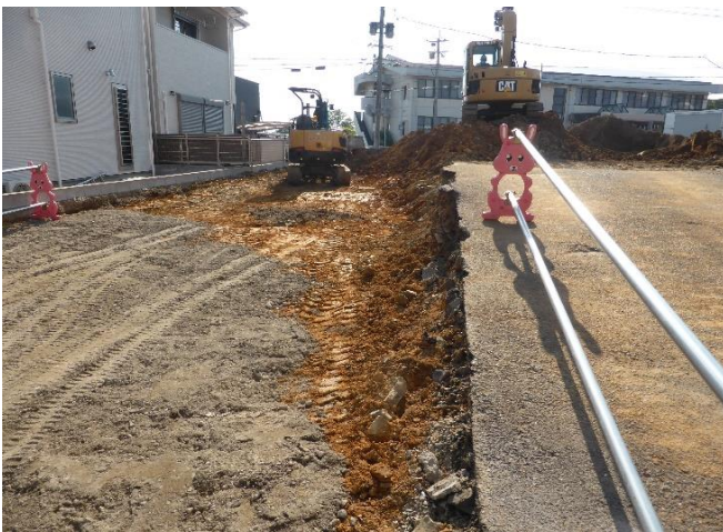
西側の道と同じ高さになった敷地を臨む
