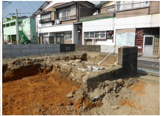
取り壊される西側駐車場入り口
